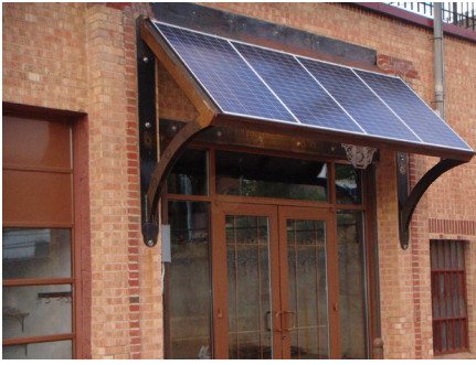
A solar awning
